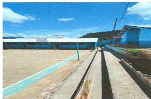
Foto 4: Reparación de torta de concreto
