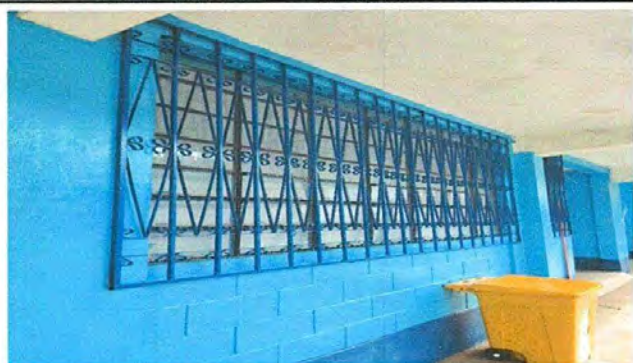
Foto 3: Mantenimiento de balcones
