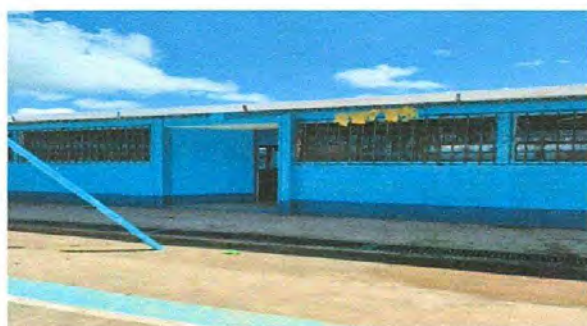
Foto 2: Pintura en muros exteriores
