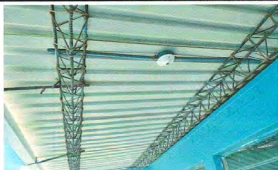
Foto 3: Sustitución de plafoneras
