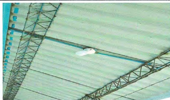
Foto 2: Sustitución de focos ahorradores
