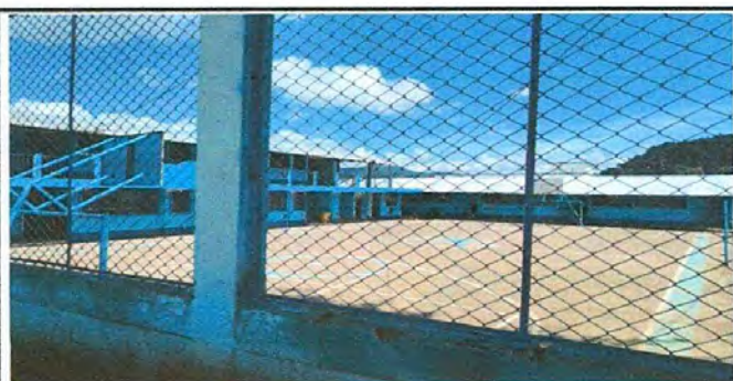
Foto 6: Reparación de muro perimetral
