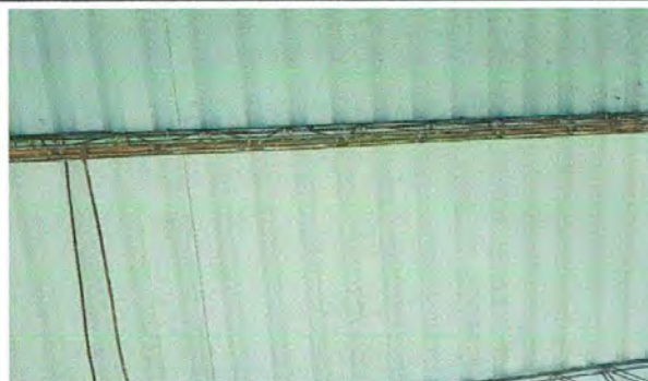
Foto 4: Reparación de cableado electrico
