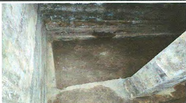
Foto 5: Limpieza de fosa séptica
