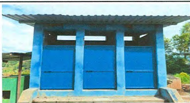
Foto 3: Mantenimiento a puertas de servicios sanitarios
