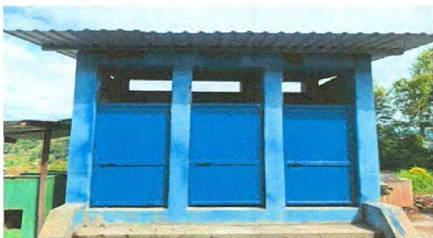
Foto1: Sustitución de techo
