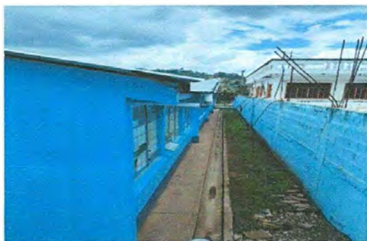
Foto 1: Reparación de bajada de agua pluvial
