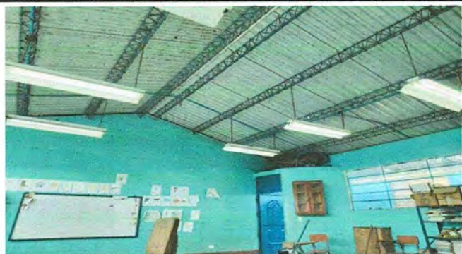
Foto1: Sustitución de lámparas
