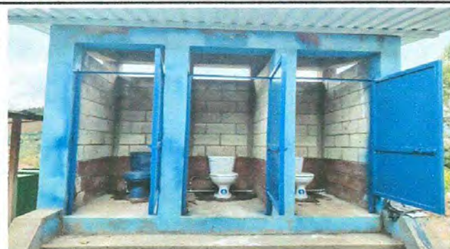
Foto 4: Sustitución de inodoros
