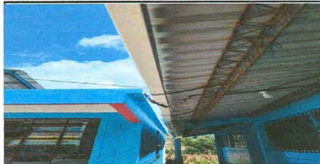
Foto 6: Sustitución de canal de pvc
